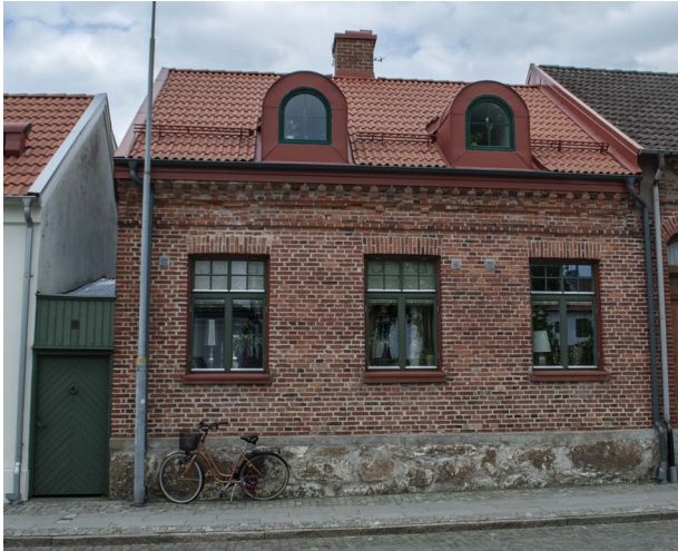
Gatufasaden med dekorativ takfot och port in till gården.
